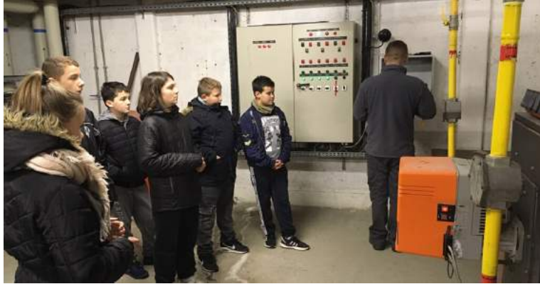
La visite de chaufferie des élèves du collège Paul Langevin
